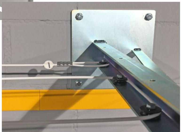
Das restliche Seil kann nun ca. 5cm nach der Walze abgeschnitten werden. Um die Spannung zu optimieren, können Sie die Leinen der Reihen nach ab der Wand nach unten ziehen, zuerst die zweithinterste, dann die dritthinterste etc. bis das restliche Seil auf dem äussersten Seil liegt. Dieses kann nun mit einer letzten Umdrehung des Seilspanners noch ganz aufgerollt werden.
